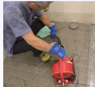
▲電動ワイヤーで尿石を物理的に除去
