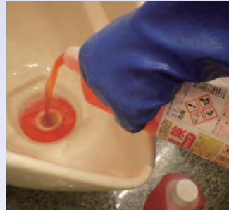
▲小便器排水管内に尿石除去剤を投入
