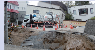
▲北海道胆振東部地震発災から10日後に撮影。液状化の影響で家が傾いたり、マンホールや土管がむき出しになってしまっている。写真提供 総合サービス株式会社様
