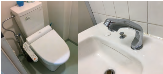
▲ウォシュレットの設置や手洗い水栓の自動化で衛生環境も改善。
