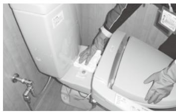
2 汚れを柔らかい布で拭きする。尿石などで汚れのひどい場合は、温水洗浄便座専用クリーナーを塗布して拭き上げる。(※酸素系洗剤を使用すると便座が割れる場合があるので注意!)
