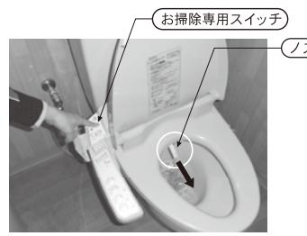
1 ノズルお掃除専用スイッチを押してノズルを出す。
