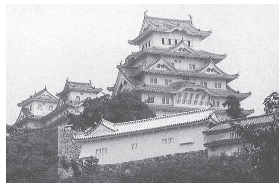
▲姫路城天守外観
